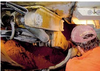
Blick auf die Tunnelvortriebsmaschine
